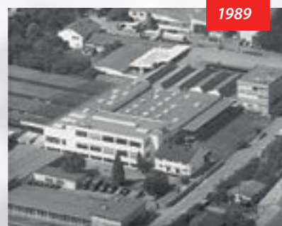
Vue aérienne du site, Bietigheim-Bissingen
